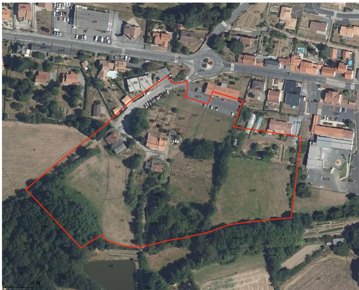
Photographie aérienne du secteur
