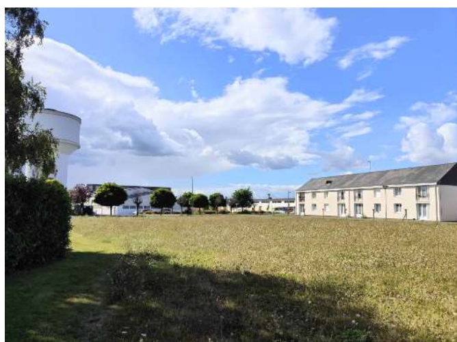
Photo n°4 - Vue des logements au Nord
