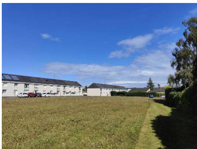
Photo n°3 - Vue des logements au Nord
