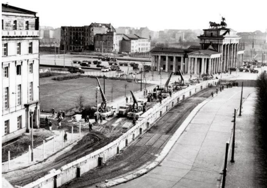
La construction du mur à la porte de Brandebourg
