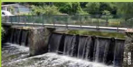
Clapet hydraulique (Èvre)
