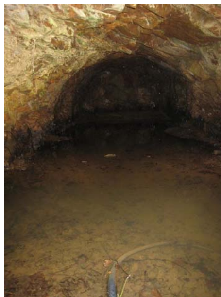
Photo 2 : Cavité en eau avec son extrémité murée
