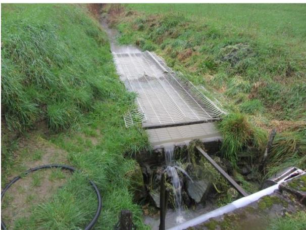
Cours d'eau rectifié et surcreusé avec obstacles à l'écoulement
