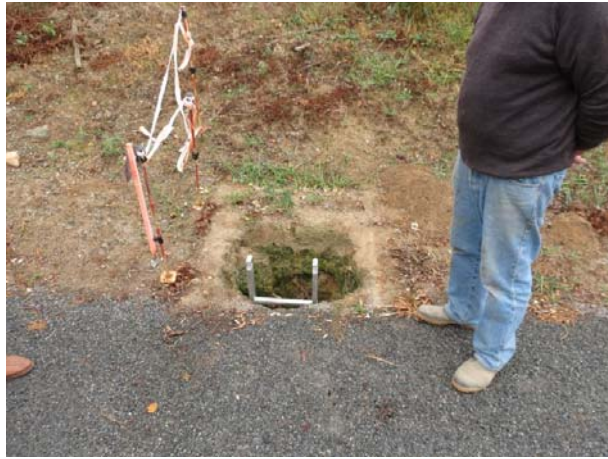
Photo 3 : Effondrement encore visible à la Guénaudière
