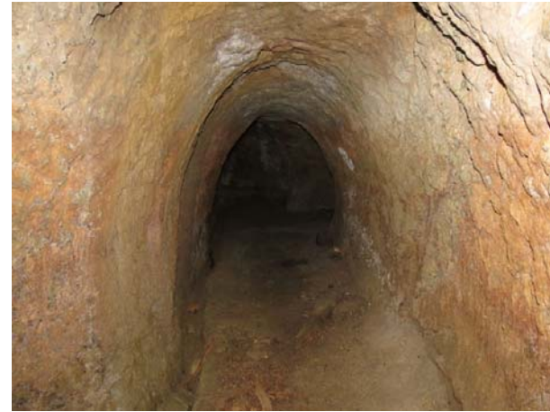
Photo 2 : Souterrain du Haut Plessis
